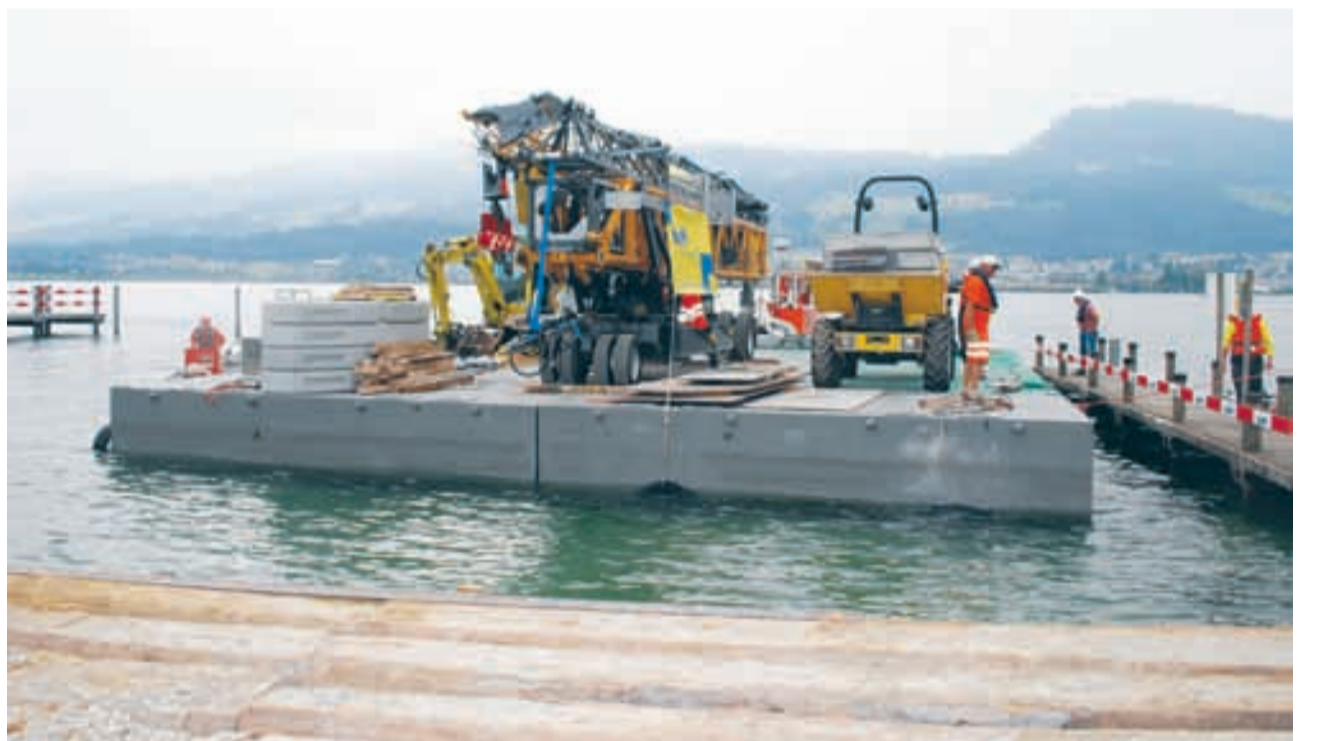
Exakt berechnet: Der Ponton ist genau gleich hoch wie die Anlagestelle.
