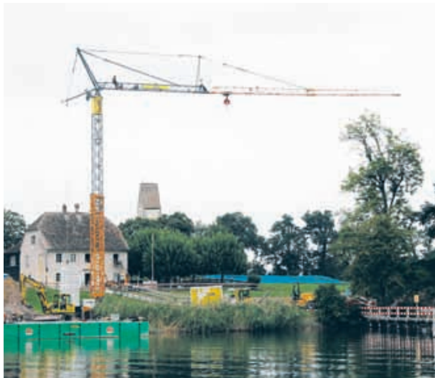
Der sogenannte Schnellmontagekran – er kann sich sozusagen selbst aufstellen – hat auf der Ufnau erst seinen zweiten Einsatz. Zuvor stand er in Wollerau.
